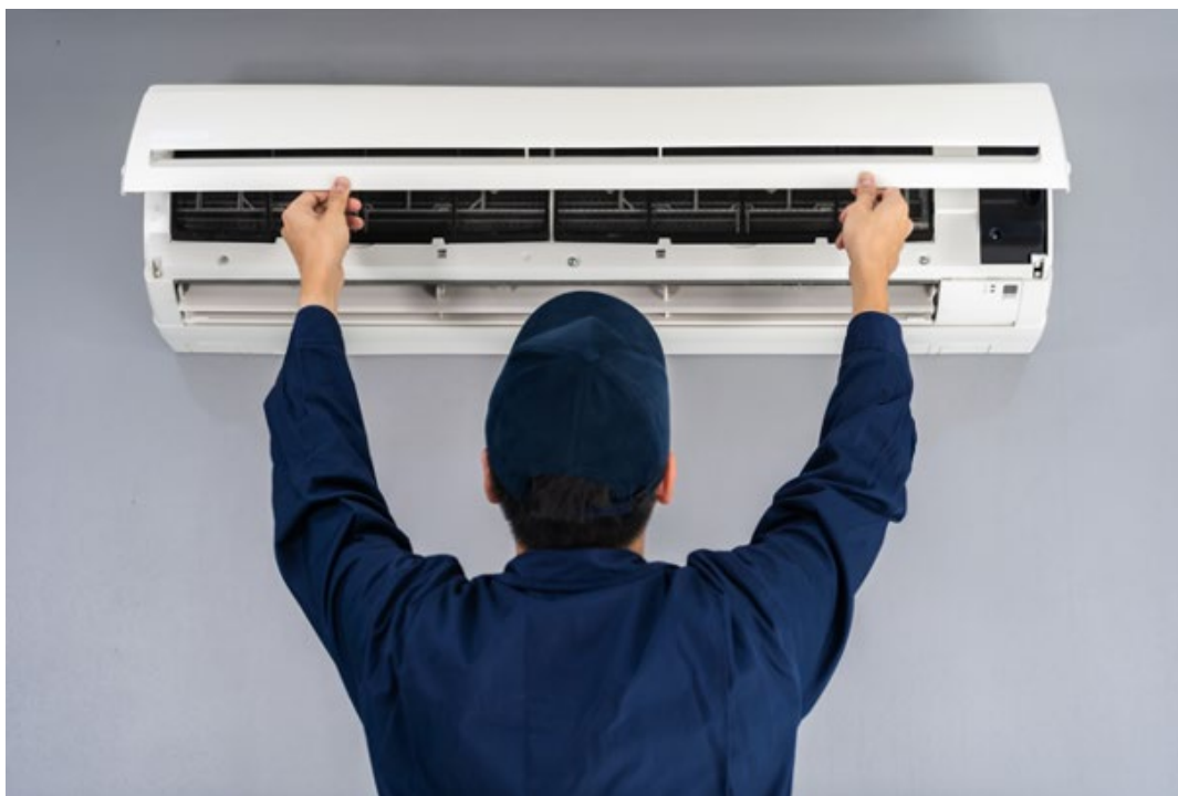
Montaż klimatyzatora. Zdjęcie dzięki uprzejmości CLASP.
