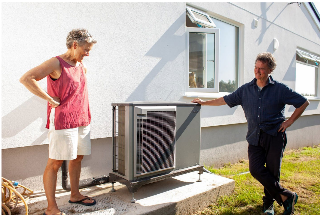
Domowa powietrzna pompa ciepła. Zdjęcie dostarczone przez Jonathana Atkinsona, podpisującego się również jako @lowwintersun .
