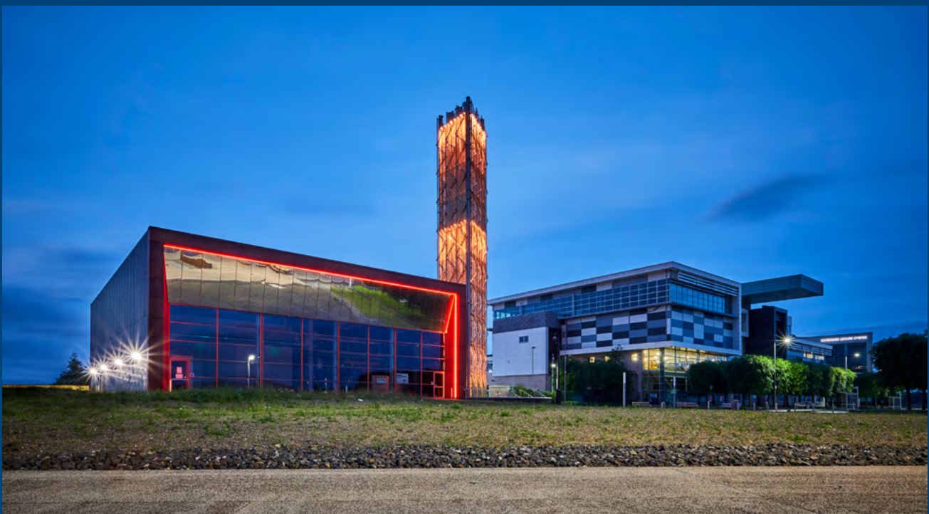
Pompe à chaleur à eau de 5,2 MW de Queen's Quay, Glasgow, Écosse. Image publiée avec l'aimable autorisation de Star Renewables.
