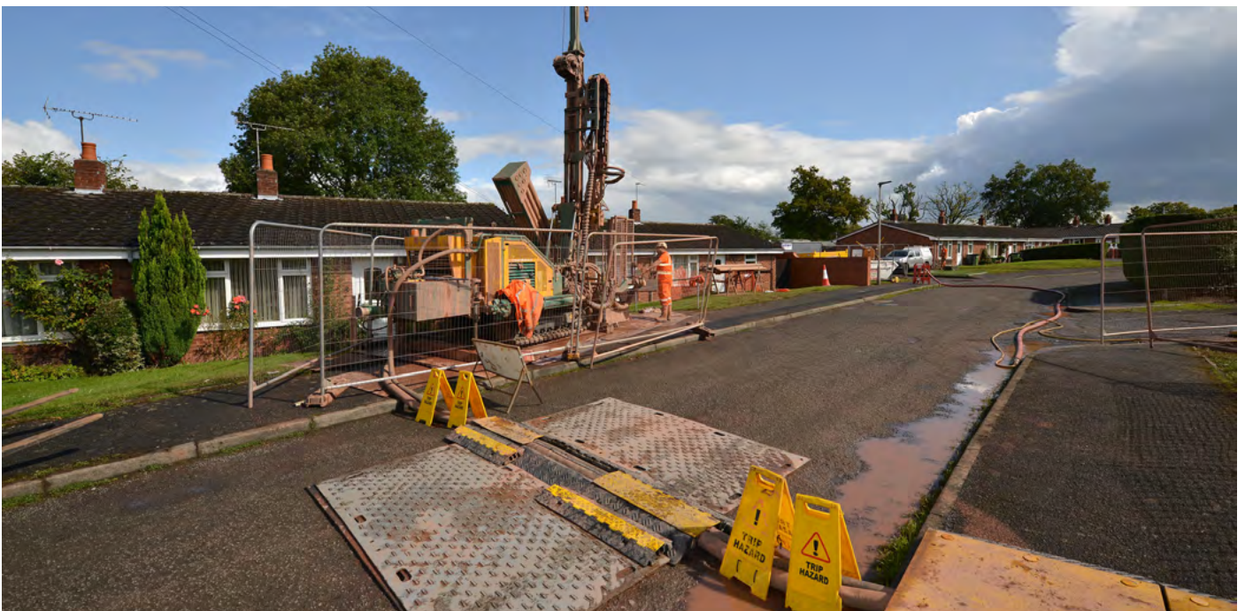
Forage de trous de sonde pour un système de pompe à chaleur à boucle géothermique partagée. Avec l'aimable autorisation de Kensa Heat Pumps.
