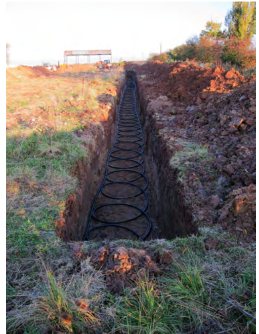
À gauche: des pompes à chaleur aérothermiques in situ (image reproduite avec l'aimable autorisation de Joe Smyth). À droite: un réseau de pompes à chaleur géothermiques de type Slinky (image reproduite avec l'aimable autorisation de David Brooke). Images reproduites avec l'autorisation de auteurs.
