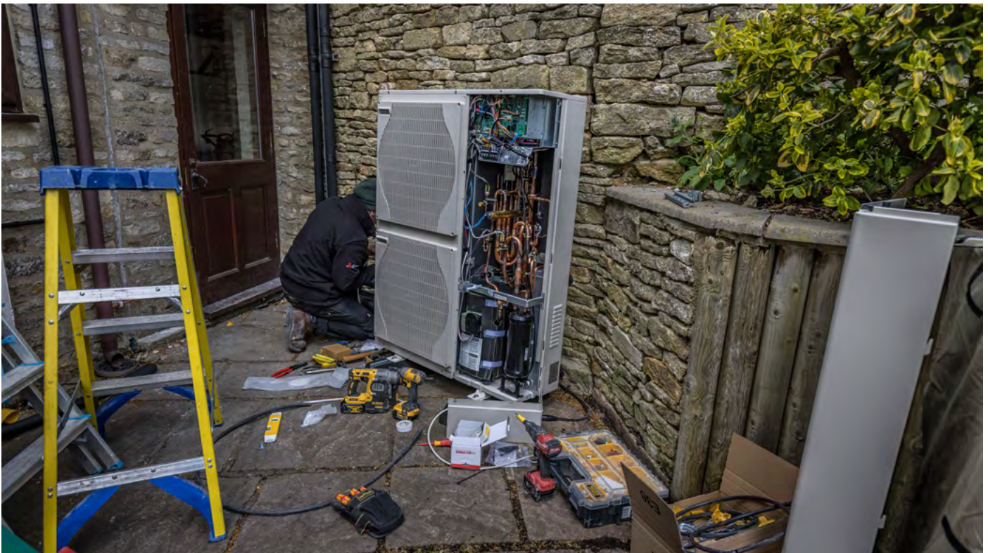
Installation d'une pompe à chaleur aérothermique. Avec l'aimable autorisation de Cotswold Energy Group.
