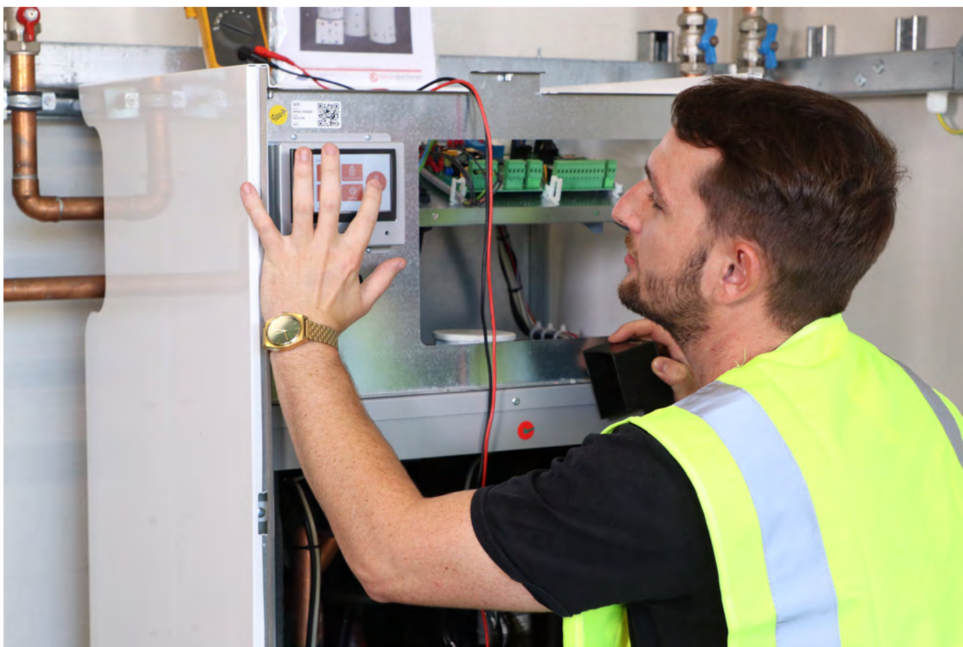
Installation d'une pompe à chaleur géothermique. Avec l'aimable autorisation de Kensa Heat Pumps.
