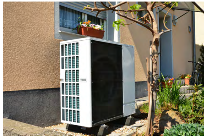
Une pompe à chaleur aérothermique à l'extérieur d'une maison. Image publiée avec l'aimable autorisation de CLASP.
