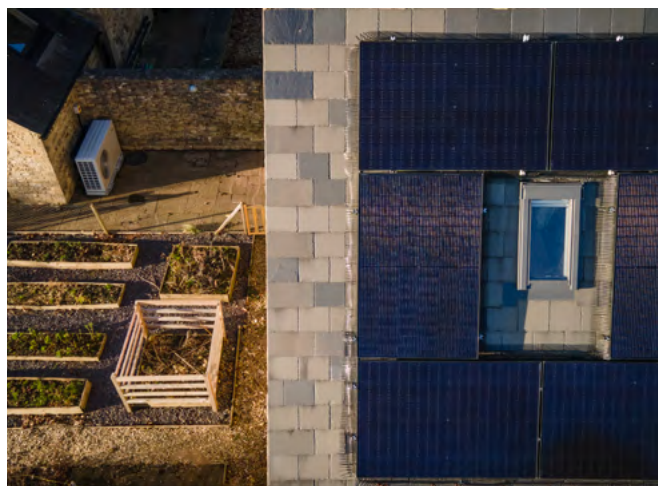
Un bâtiment équipé d'une pompe à chaleur et d'un système photovoltaïque. Image publiée avec l'aimable autorisation de Cotswold Energy.
