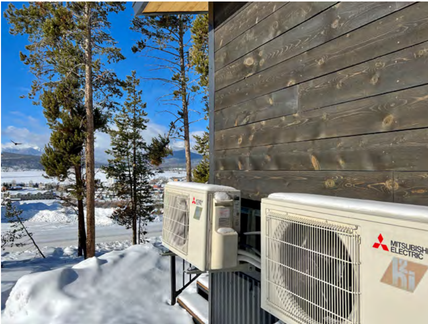
À gauche: des pompes à chaleur aérothermiques in situ (image reproduite avec l'aimable autorisation de Joe Smyth). À droite: un réseau de pompes à chaleur géothermiques de type Slinky (image reproduite avec l'aimable autorisation de David Brooke). Images reproduites avec l'autorisation de auteurs.
