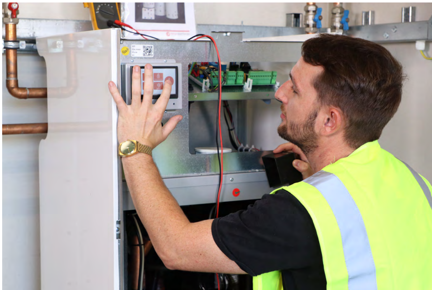
Instalacja gruntowej pompy ciepła. Zdjęcie dzięki uprzejmości Kensa Heat Pumps.
