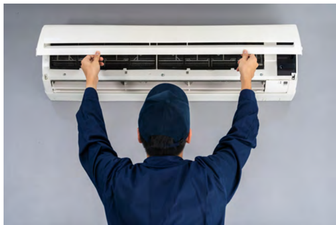
Montaż jednostki wewnętrznej pompy ciepła typu powietrze-powietrze. Zdjęcie dzięki uprzejmości CLASP.
