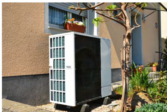
Powietrzna pompa ciepła na zewnątrz domu. Zdjęcie dzięki uprzejmości CLASP.
