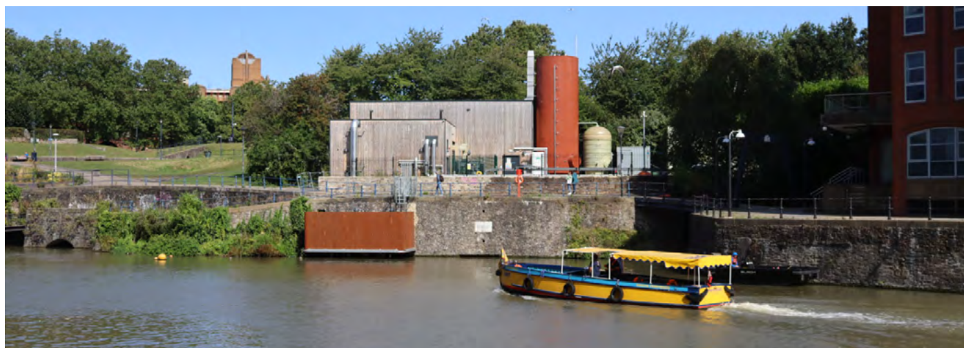
Pompa ciepła pobierająca ciepło z wody w Castle Park w Bristolu. Zdjęcie dzięki uprzejmości Star Renewables.
