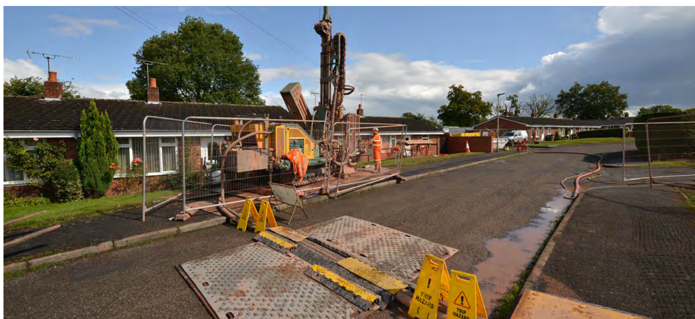
Wiercenie odwiertów pod współdzielone dolne źródło pompy ciepła. Zdjęcie dzięki uprzejmości Kensa Heat Pumps.
