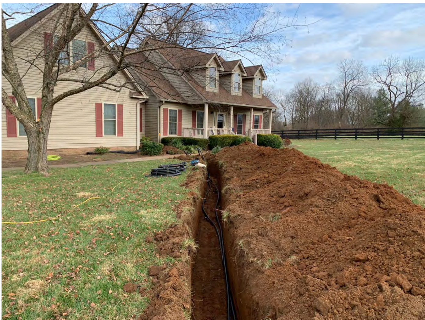
Wykop pod instalację gruntowej pompy ciepła. Zdjęcie dzięki uprzejmości Danielsen_Photography/Shutterstock .
