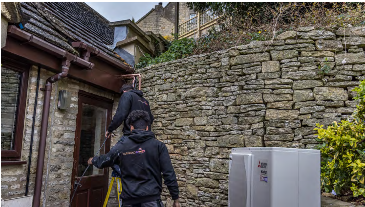
Instalacja powietrznej pompy ciepła. Zdjęcie dzięki uprzejmości Cotswold Energy Group.
